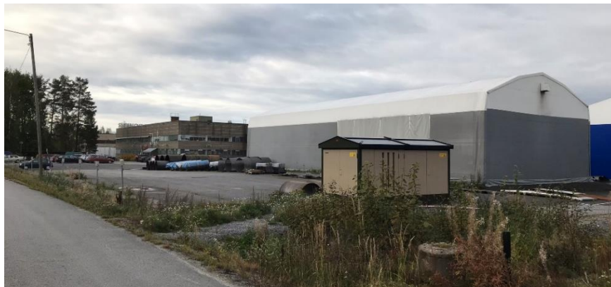
Kuva 3. Nykyiset teollisuusrakennukset alueella.
