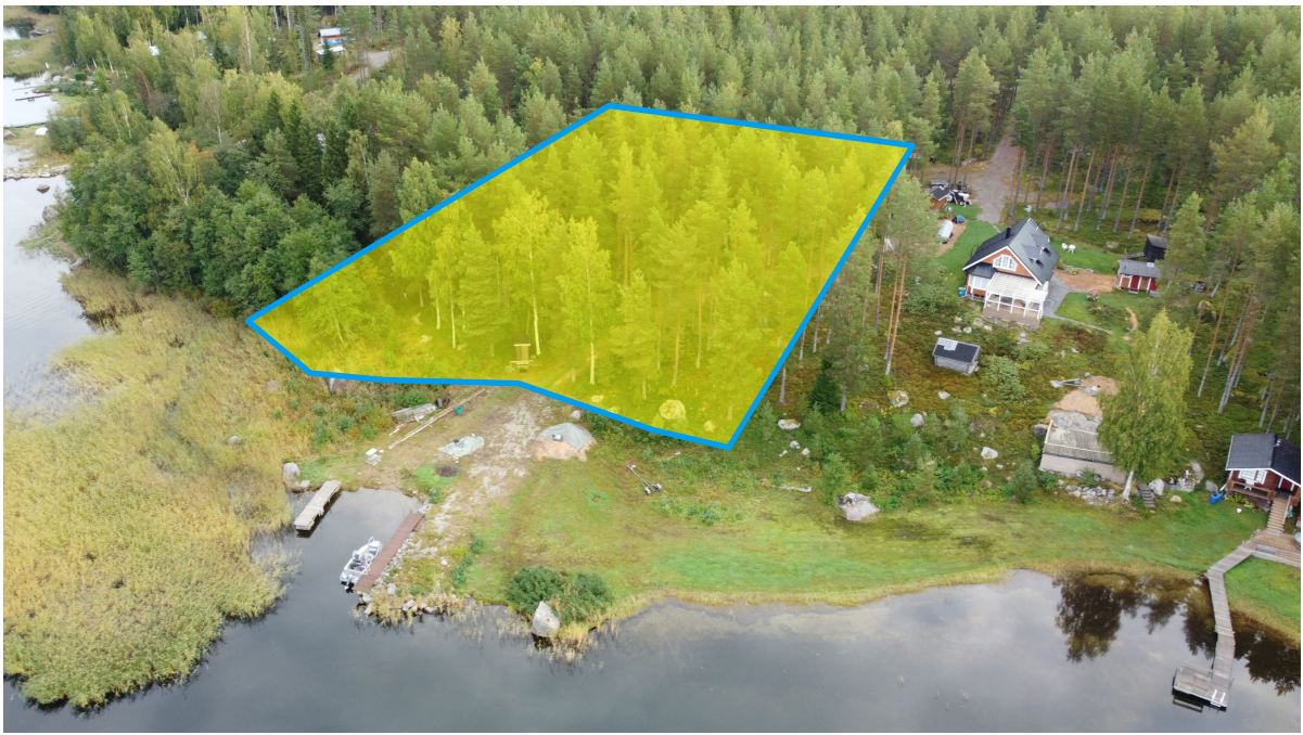
Bild 17. Riktgivande område varifrån man flyttar byggplatsen.
