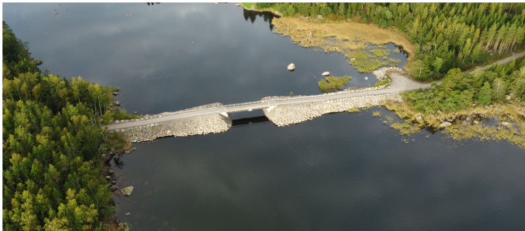
Kuva 12. Vastarakennettu silta Pirklotista Korpeslotille.
