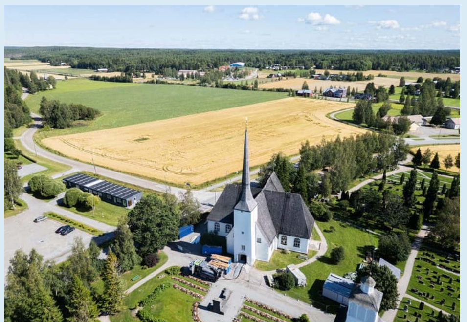
Renovering pågår. Vörå kyrka ska stå klar passligt till hösten 2026 då den firar 400 år.
