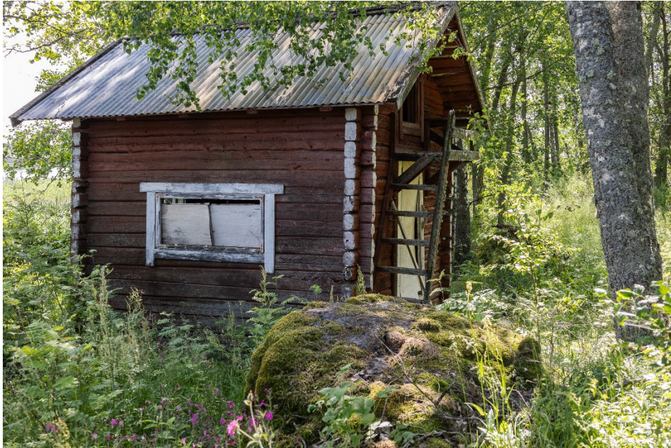
Bild 4. Byggnaden på Jaksgrundet är en äldre häbreliknade stockbyggnad.
