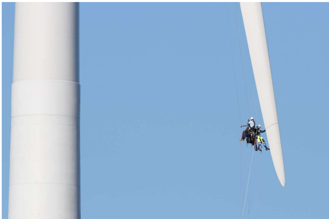
Bild 26. Underhåll av vindkraftverk (Bild: FCG).
