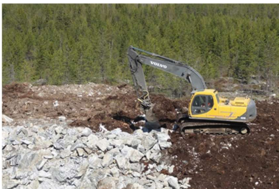
Bild 20. Byggandet av vindkraftsparken inleds med att bygga vägar och lyftområden. (bilder: FCG).
