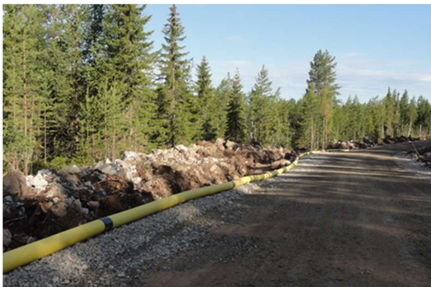
Bild 16. Till vänster ett exempel på byggnads- och servicevägar i vindkraftsparken. Vägarna används bland annat för transport av betong, grus och kraftverkskomponenter samt för servicekörningar i vindkraftsparkens driftsskede. Jordkabeln placeras i ett dikesschakt i kanten av vägen. Till höger delar till vindkraftverk som transporteras som specialtransporter. (Bilder: FCG).
