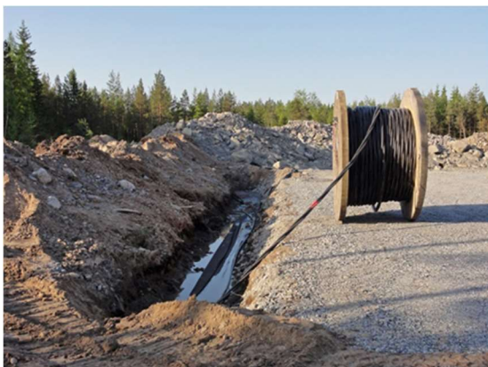
Bild 21. Jordkablarna grävs ner i anslutning till servicevägarna (Bilder: FCG).
