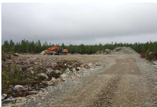
Bild 20. Byggandet av vindkraftsparken inleds med att bygga vägar och lyftområden. (bilder: FCG).
