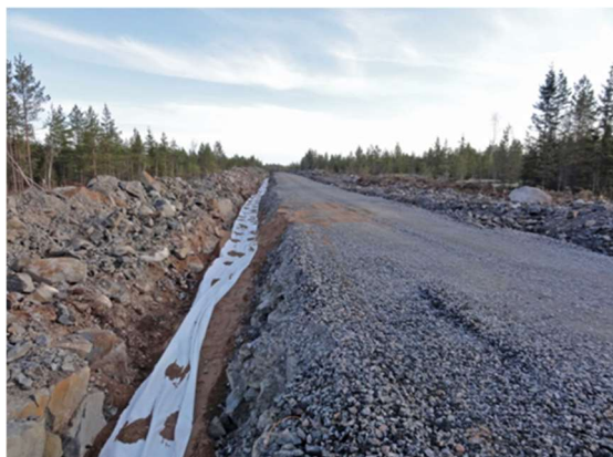
Bild 21. Jordkablarna grävs ner i anslutning till servicevägarna (Bilder: FCG).
