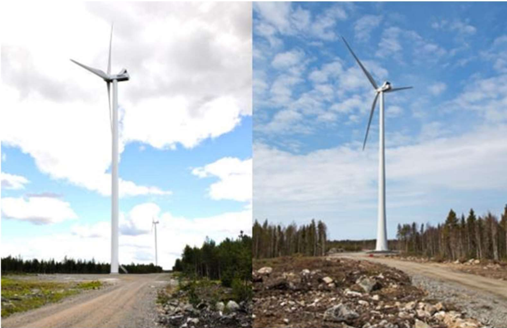
Bild 10. Till vänster ett exempel på ett cylindertorn och till höger ett hybridtorn. (Bilder: Leila Väyrynen, FCG)
