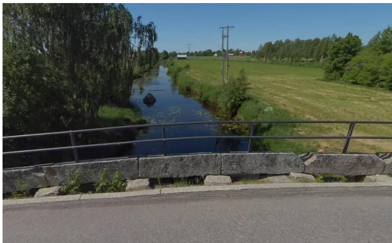
Figur 14. Toby stenbro, exempel på höjning av räcken.
