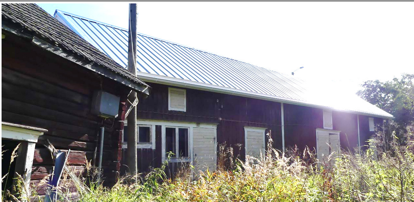
Gårdsbyggnaden längs Råndasvägen, fotograferad från nordväst.
