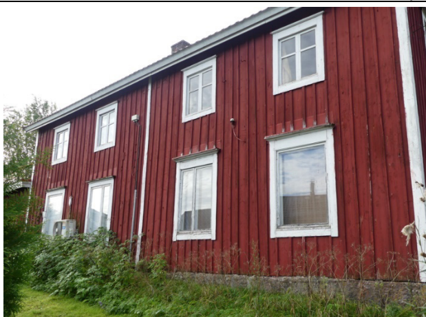
Fasaden mot nordost.
