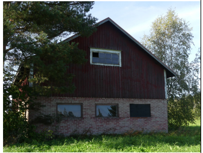
Gårdsbyggnaden från öster.
