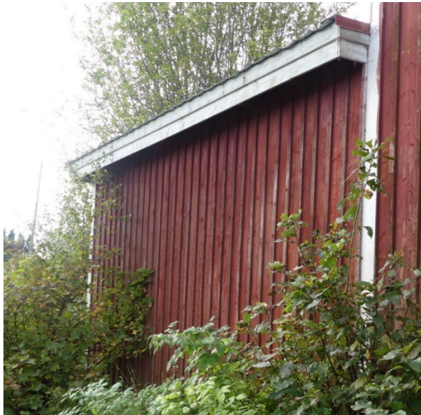
Utbyggnad från nordöstra sidan.
