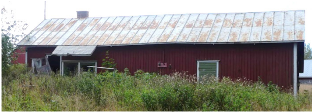
Gårdsbyggnaden sedd från gårdsplanen.
