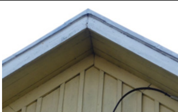
Detalj vid takfoten.
