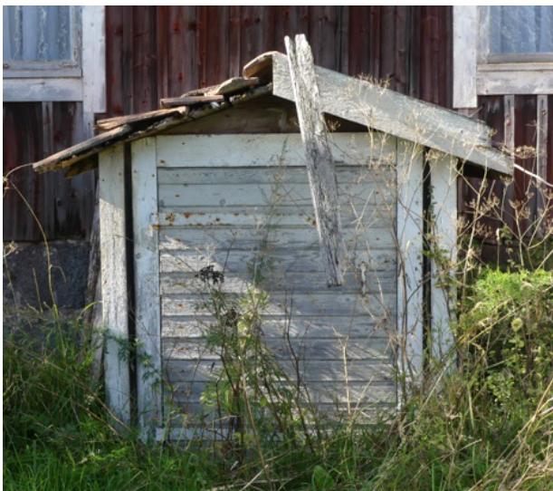
Ingång till källaren på farstukvistens södra sida.
