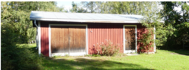
Gårdsbyggnaden fotograferad från söder.
