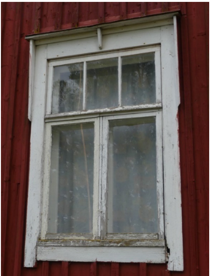
Nedre fönster i nordvästra gaveln.
