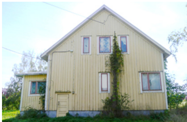
Bostadshuset sett norrifrån.
