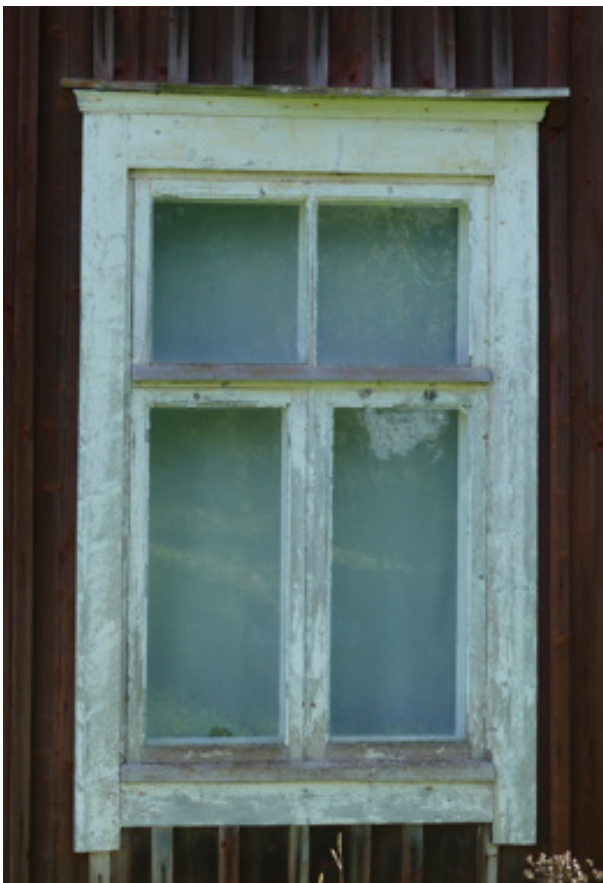
Fönster på västra sidan.
