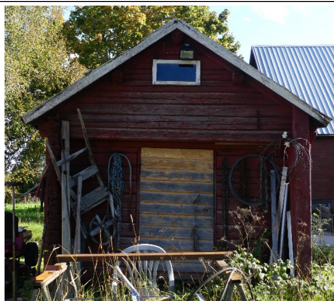
Mindre gårdsbyggnad på bakgården, fotograferad från väster.
