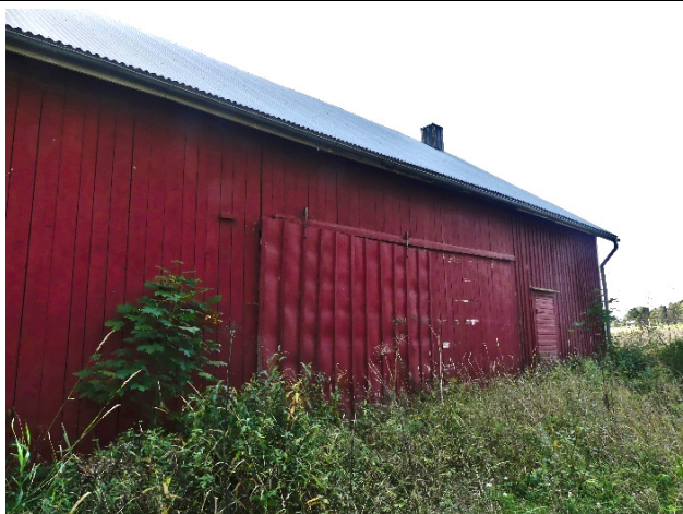
Gårdsbyggnaden från nordost.
