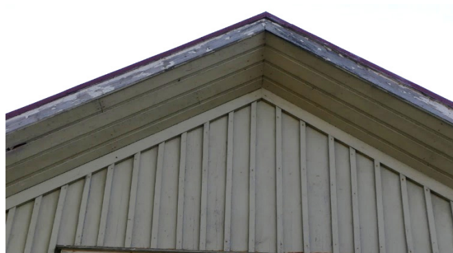
Inbeklädnad av takfot.
