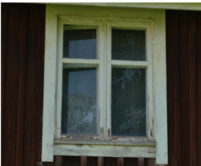
Högre fönster i andra våningen.
