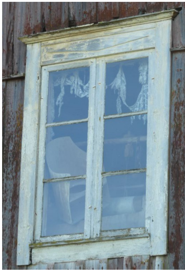
Fönster på norra gaveln i andra våningen.
