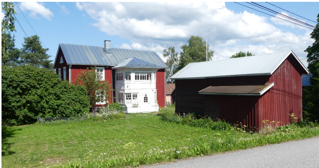
Kuva 8. Rakennuksia Råndaksentien varressa.
