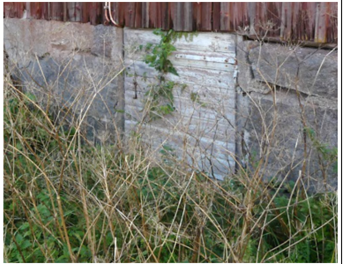
Kellarin sisäänkäynti kuistin pohjoispuolella.
