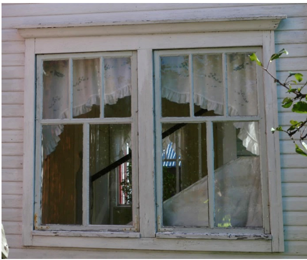
Ensimmäisen kerroksen ikkunapari.
