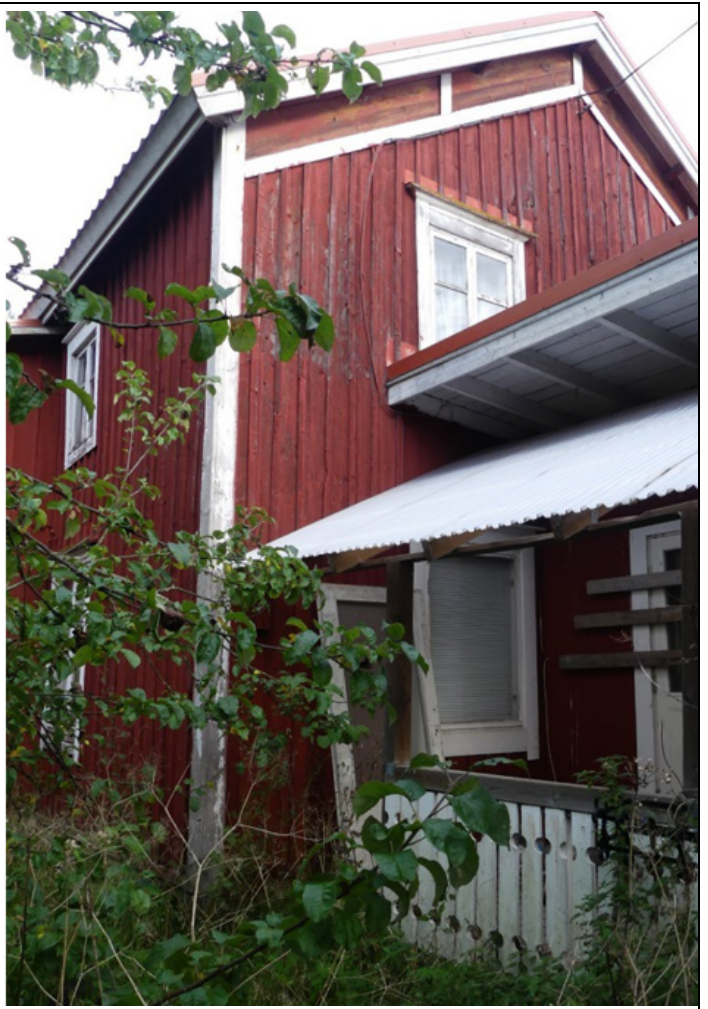
Talon kaakkoispäättyyn myöhemmin rakennettu veranta laajennuksen yhteyteen.
