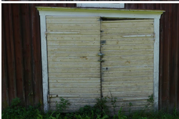
Piharakennuksen luukku ja ovia.
