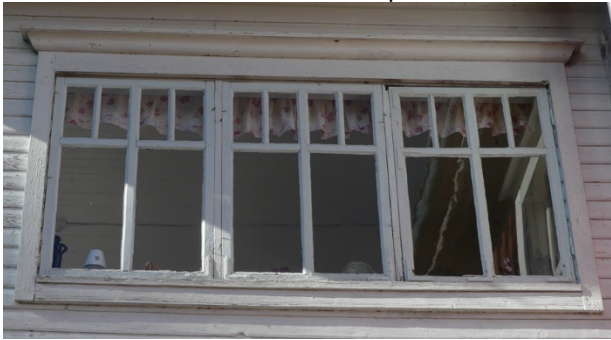
Toisen kerroksen ikkuna
