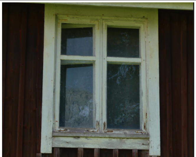
Korkeampi 2. kerrroksen ikkuna.
