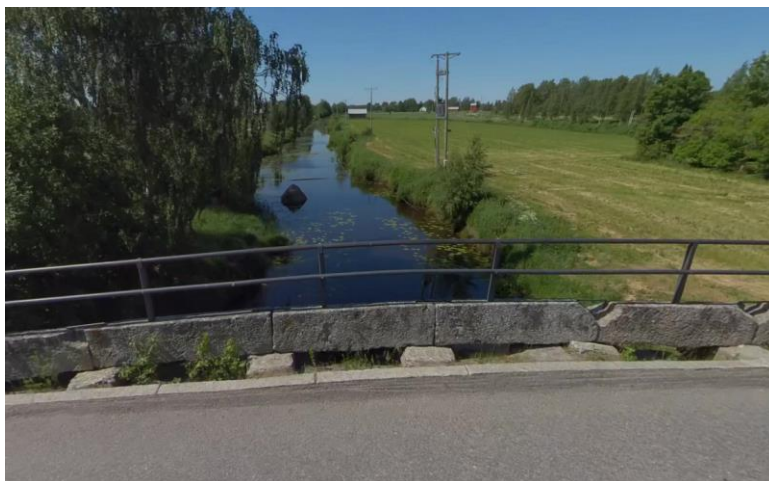
Kuva 14. Tuovilan kivisilta, esimerkkikohde kaiteiden korottamisesta.
