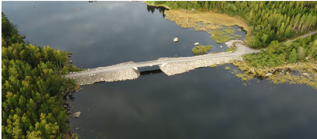
Kuva 14. Vastarakennettu silta Pirklotista Korpeslotille.
