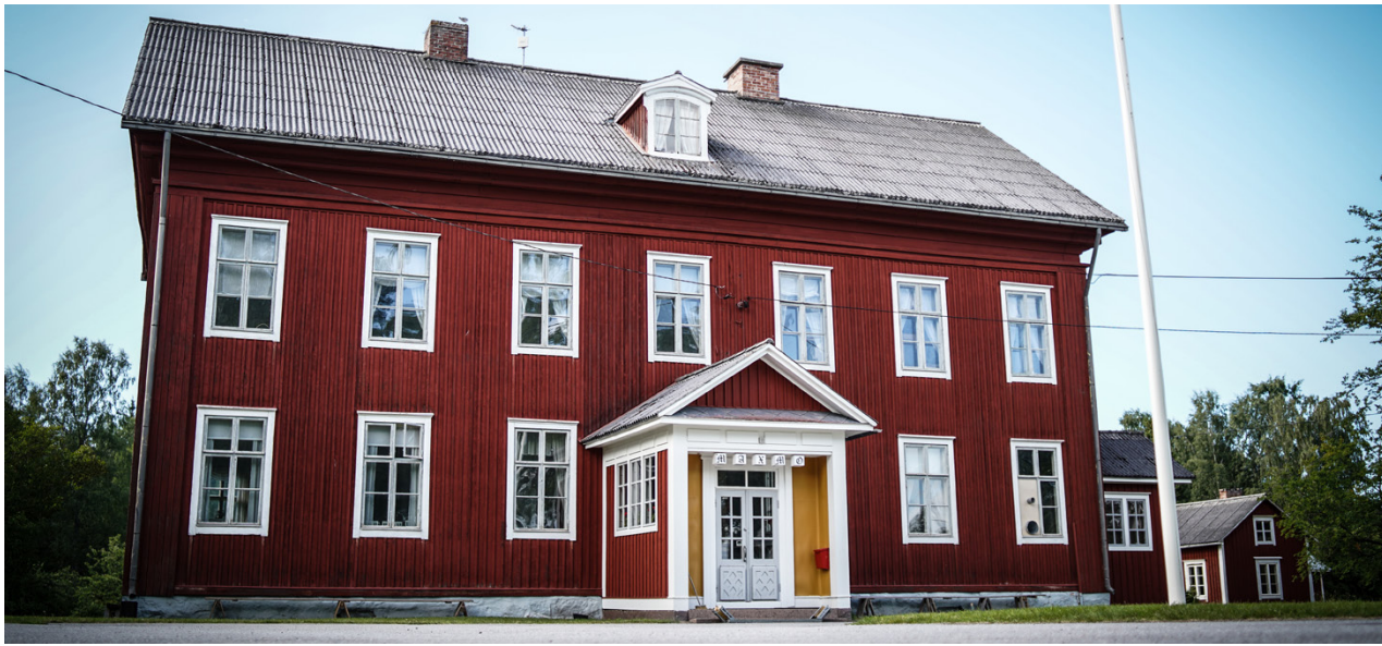
I Tottesunds herrgård håller en renovering på att utföras.
