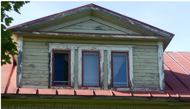
Fronton på östra takhalvan.
