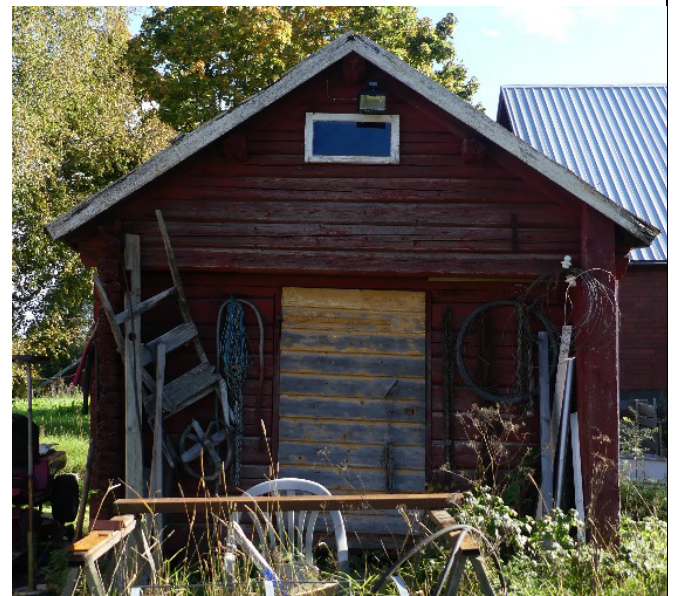
Mindre gårdsbyggnad på bakgården, fotograferad från väster.
