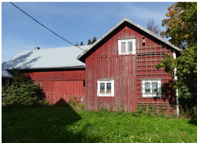
Gårdsbyggnaden från innergården.
