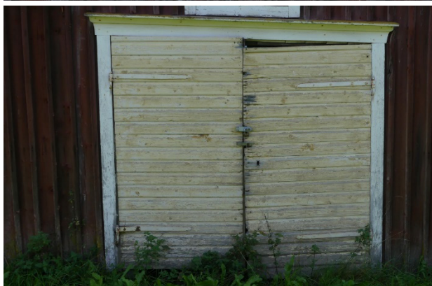
Lucka och dörrar på gårdsbyggnaden.
