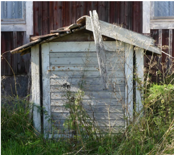
Ingång till källaren på farstukvistens södra sida.
