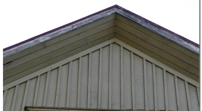
Inbeklädning av takfot.
