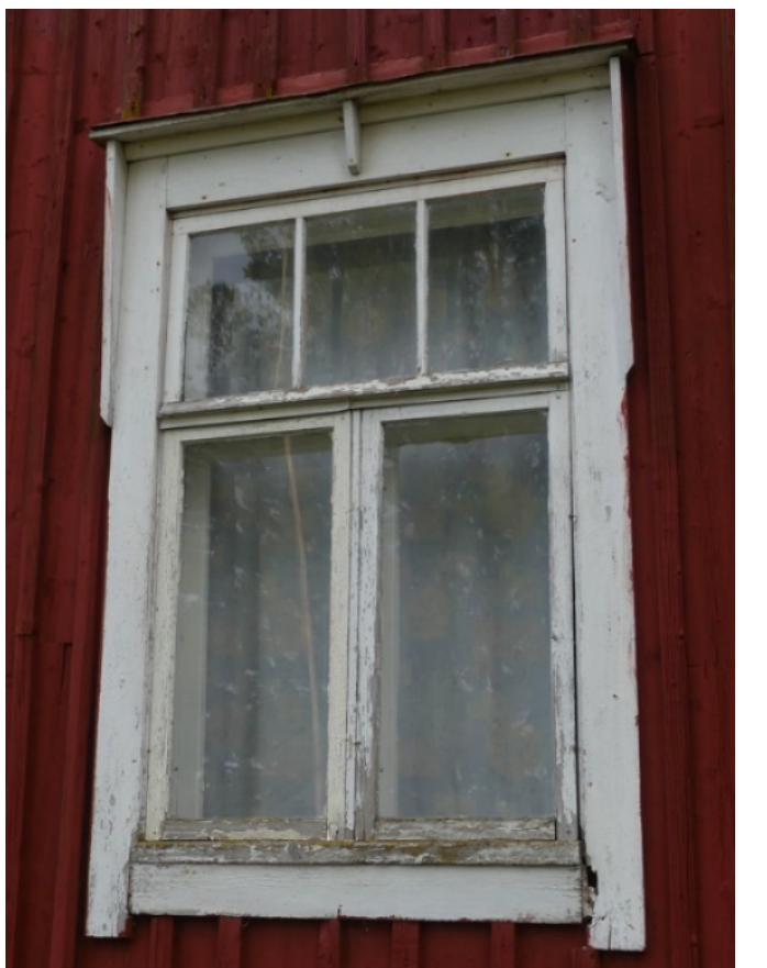
Nedre fönster i nordvästra gaveln.
