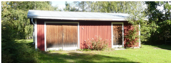
Gårdsbyggnaden fotograferad från söder.
