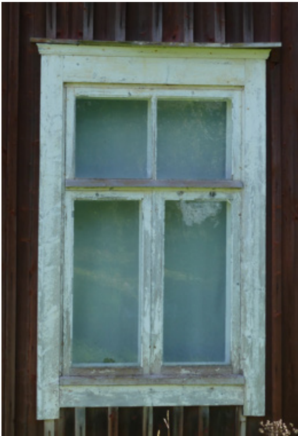
Fönster på västra sidan.
