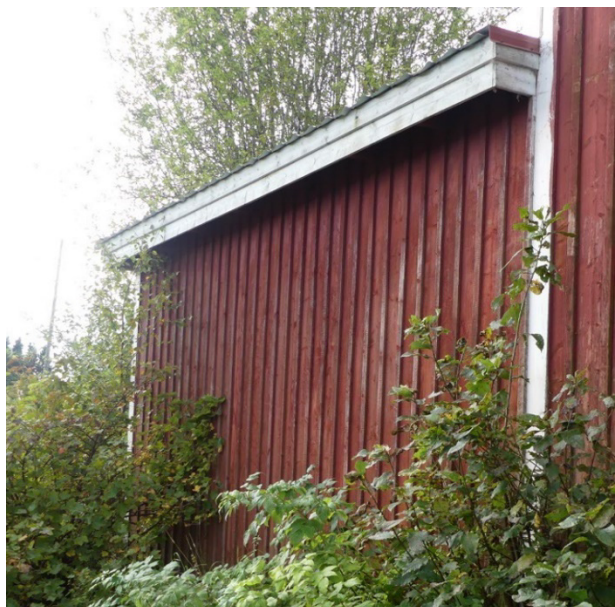
Utbyggnad från nordöstra sidan.
