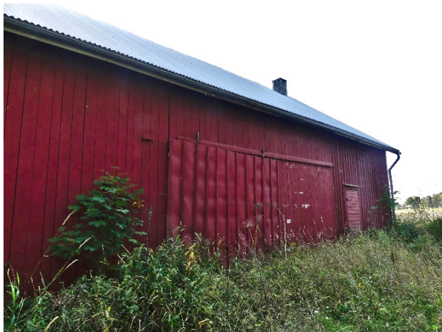
Gårdsbyggnaden från nordost.
