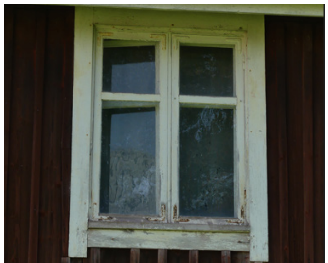
Högre fönster i andra våningen.
