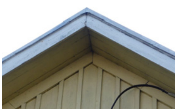
Detalj vid takfoten.
