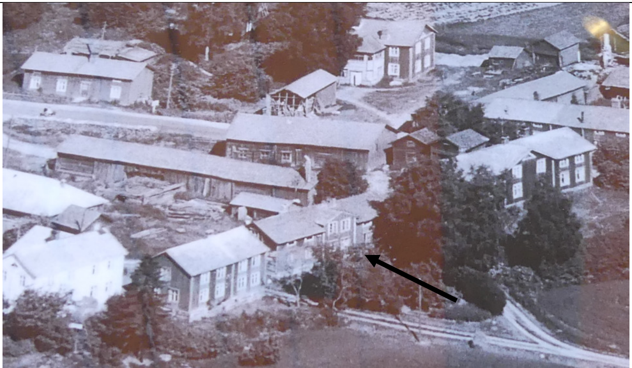
Delförstörning av gårdstunet, tagen ur fastighetsinnehavarens flygbild. Bostadshuset visas med en pil. Det omgivande byggnadsbeståndet på södra sidan av Råndasvägen har till största delen försvunnit.
