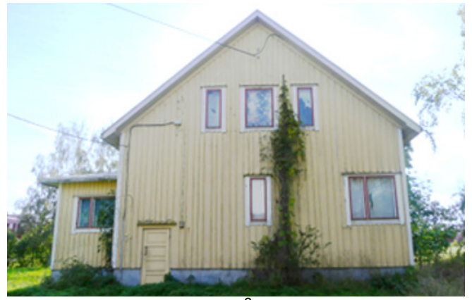
Bostadshuset sett norrifrån.
