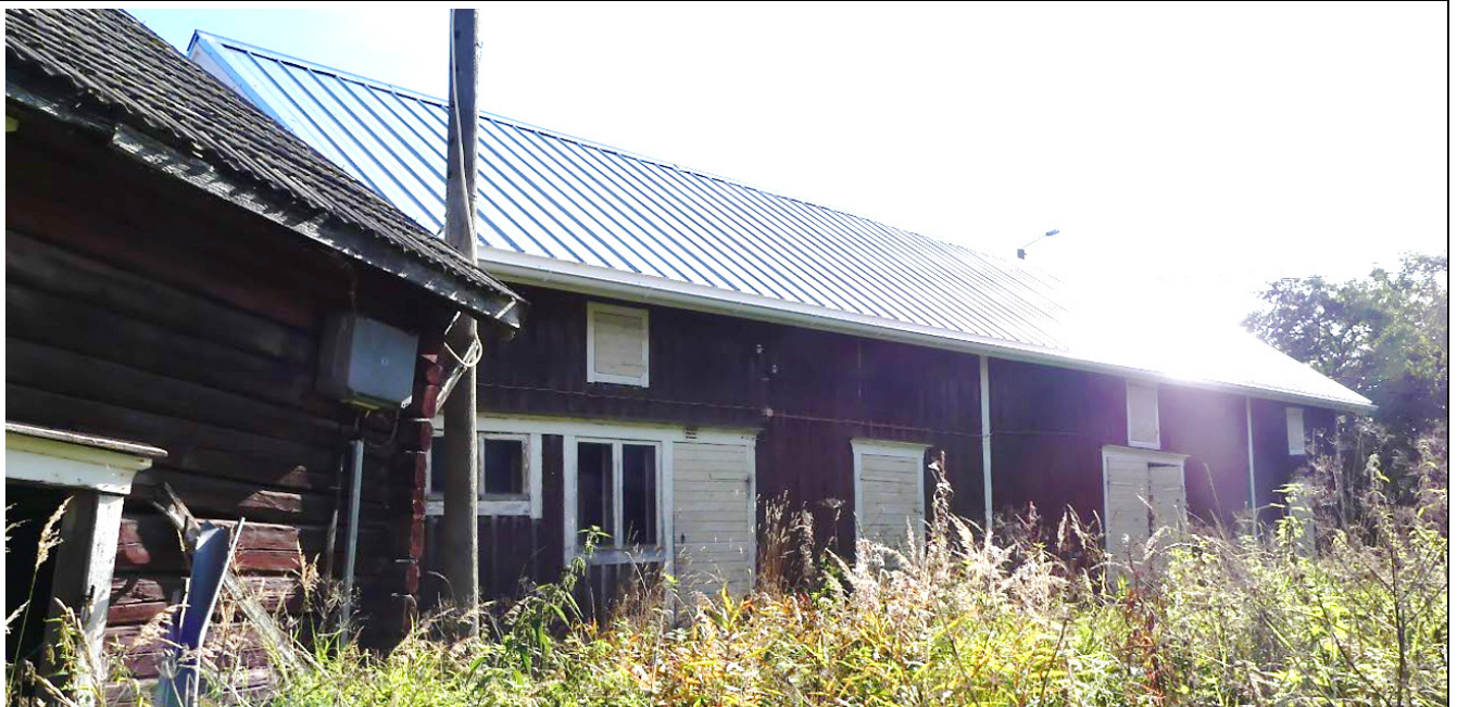
Gårdsbyggnaden längs Råndasvägen, fotograferad från nordväst.
