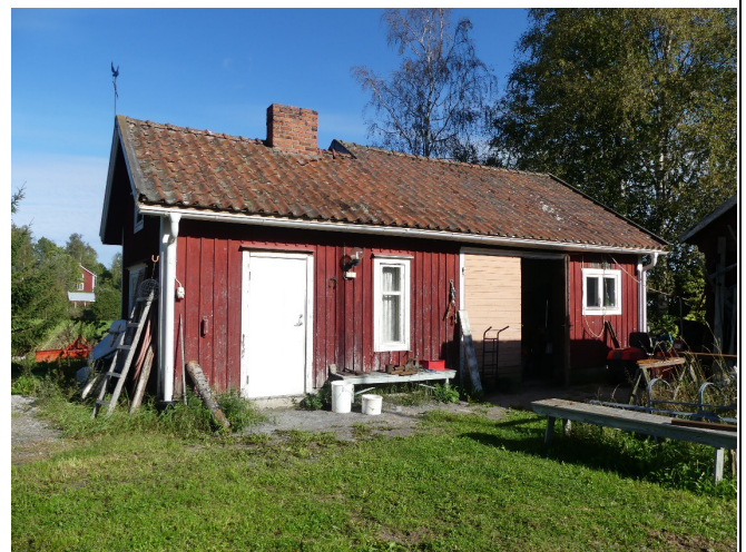
Den större gårdsbyggnaden i norra delen av gårdstunet, fotograferad från söder.
