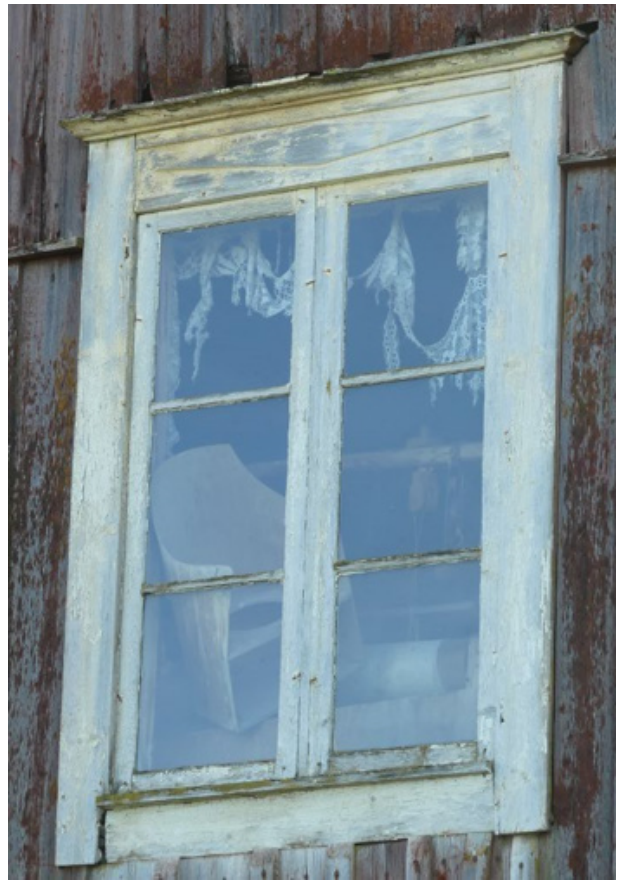
Fönster på norra gaveln i andra våningen.
