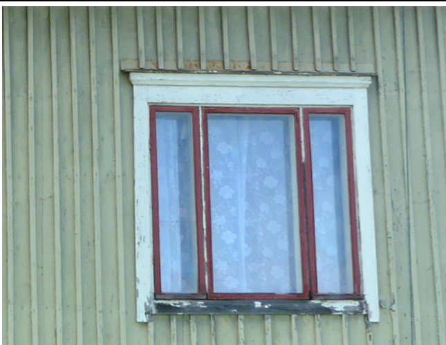
Fönster på östra sidan.
