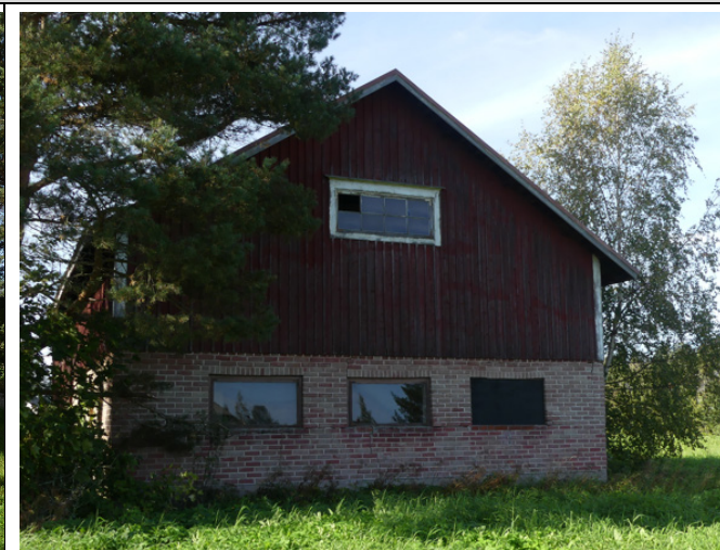
Gårdsbyggnaden från öster.
