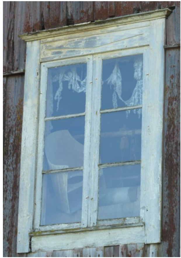
Toisen kerroksen pohjoispäädyn ikkuna.
