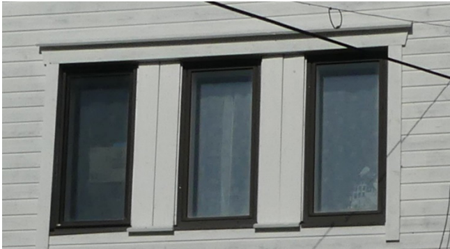
Toisen kerroksen ikkuna eteläpäädyllä.
