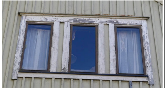
Toisen kerroksen ikkuna pohjoispäädyllä.
