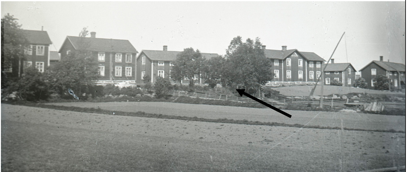
Vöyriläistä rykelmäkylää todennäköisimmin 1900-luvun alusta. Inventointikohte on kuvassa keskellä nuolen osoittamassa paikassa. (Vöyrin kunnan arkisto)
