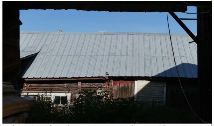
Pohjoisin piharakennus porttisolasta nähtynä.
