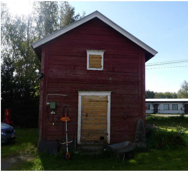
Lähinnä tietä sijaitseva piharakennus pohjoisesta. Taustalla näkyy 1970-luvun valkoinen rivitalo Rändaksentien toisella puolen.
