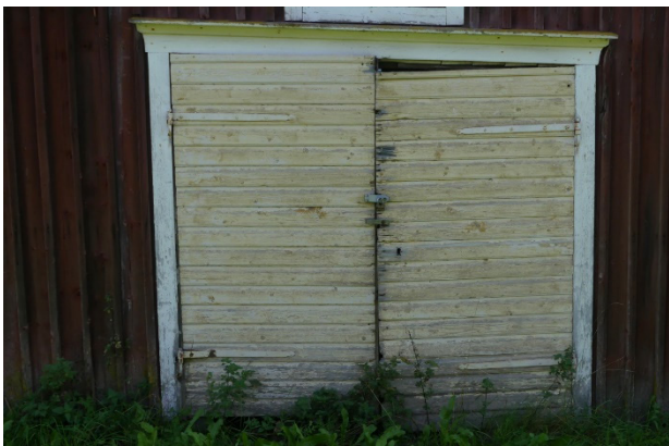
Piharakennuksen luukku ja ovia.
