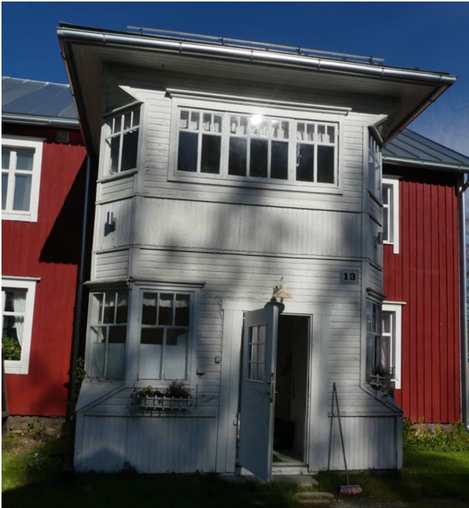
Kuistissa on viistetyt nurkat ja koristeellinen panelointi.
