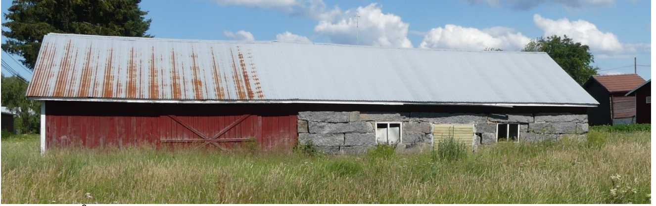
Kivinavetta Rändaksentien suunnasta etelästä. Lautaverhoiltu osa on rakennettu 1950-luvun jälkeen.
