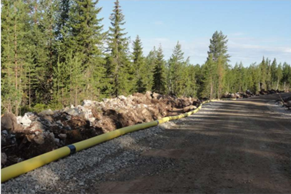
Kuva 16. Vasemmalla esimerkki tuulivoimapuiston rakennus- ja huoltotiestä. Teitä käytetään muun muassa betonin, soran ja voimaloiden komponenttien kuljetuksiin sekä tuulivoimapuiston käyttövaiheessa huoltoajoihin. Maakaapeli sijoitetaan ojakaivantoon tien reuna-alueelle. Oikealla tuulivoimalan osia kuljetetaan erikoiskuljetuksina. (Kuvat: FCG).
