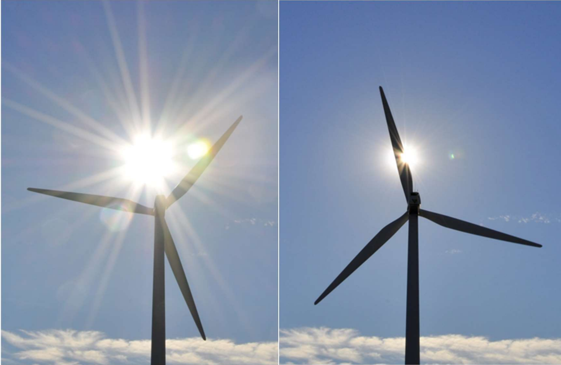
Kuva 94. Tuulivoimaloiden lavat aiheuttavat pyöriessään vilkkumista ja varjon välkkymistä aurinkoisella säällä.
