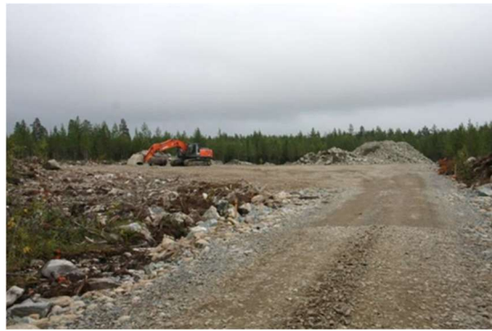
Kuva 20. Tuulivoimapuiston rakentaminen alkaa huoltoteiden ja pystytysalueiden rakentamisella (Kuvat: FCG).
