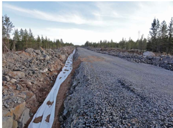
Kuva 21. Maakaapelit upotetaan huoltoteiden yhteyteen (Kuvat: FCG).
