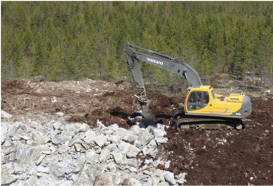
Kuva 20. Tuulivoimapuiston rakentaminen alkaa huoltoteiden ja pystytysalueiden rakentamisella (Kuvat: FCG).
