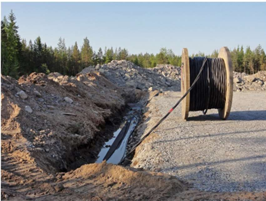
Kuva 21. Maakaapelit upotetaan huoltoteiden yhteyteen (Kuvat: FCG).
